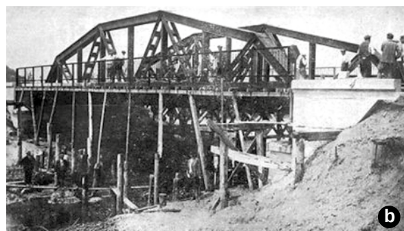
Figura 6. Primul pod sudat din Europa (Polonia, 1929) – a. astăzi, b. imediat după construire Figure 6. First welded bridge in Europe (Poland, 1929) – a. nowadays, b. after the building
