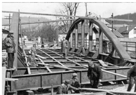
Figura 10. Aspecte din timpul construcției structurii [8] Figure 10. Aspects during the erection of the structure [8]
