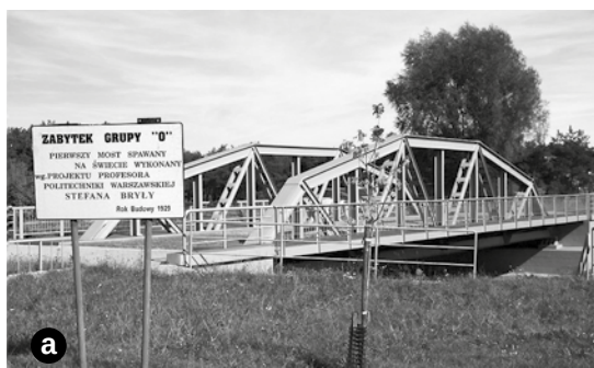
Figura 6. Primul pod sudat din Europa (Polonia, 1929) – a. astăzi, b. imediat după construire Figure 6. First welded bridge in Europe (Poland, 1929) – a. nowadays, b. after the building
