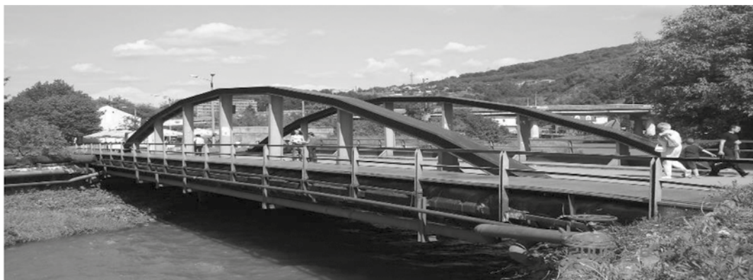
Figura 9. „Podul Vamal” – Reșița; fotografie actuală Figure 9. „Podul Vamal” bridge – Reșița; nowadays photo
