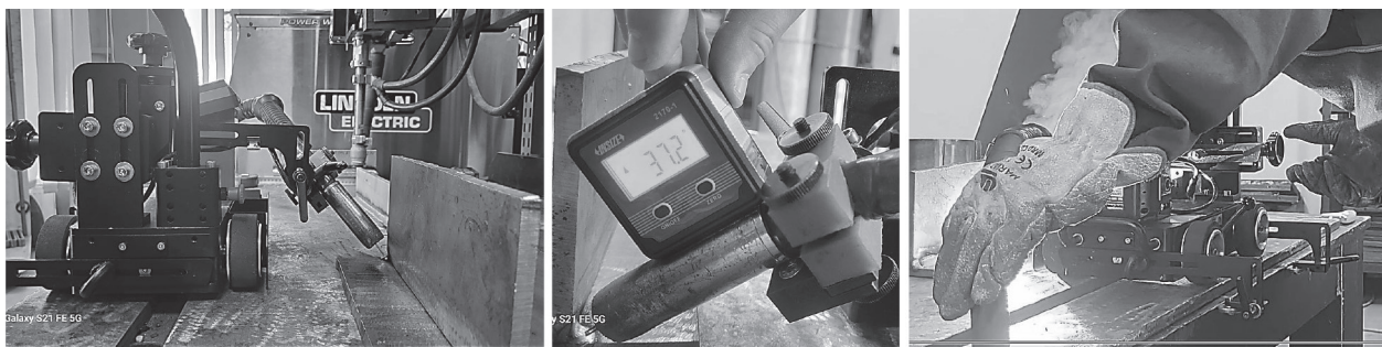
Figura 16. Sudare în sistem mecanizat Figure 16. Mechanized welding system
