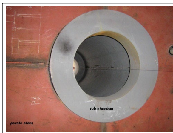
Fig. 4 Centrarea celor 3 piese, cu sârma tensionată
